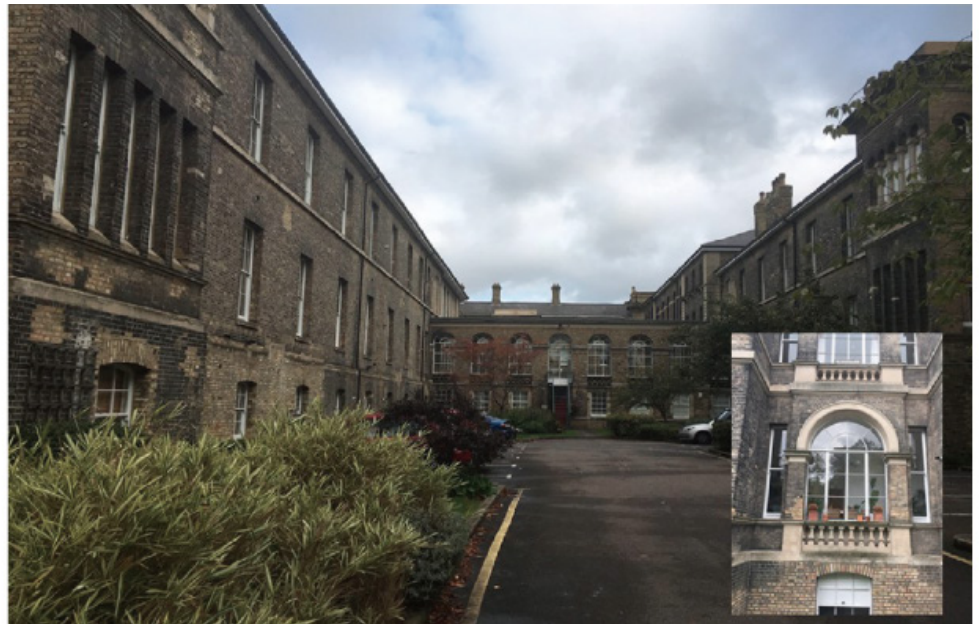
図4：ハーバート病院の ナイチンゲール病棟、 ロンドン（写真：筆者 撮影）
